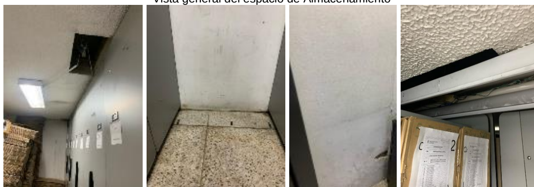
Detalle del estado de los elementos constructivos
